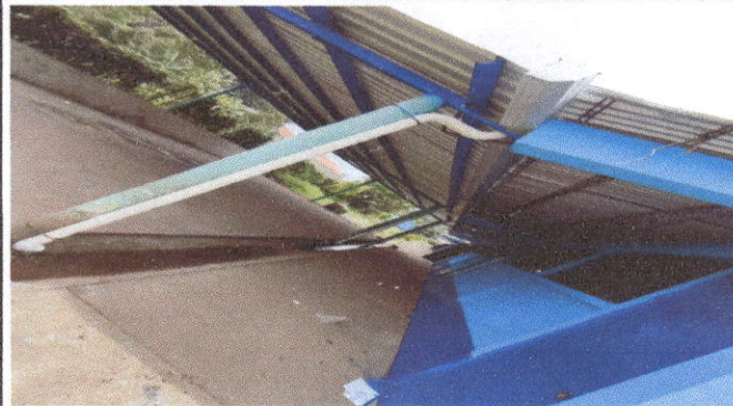
Foto 2: Estructura de techo.
