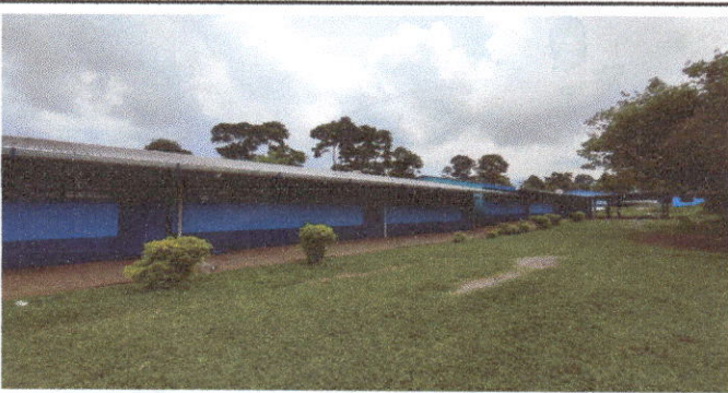
Foto 5: Pintura de muros exteriores e interiores.
