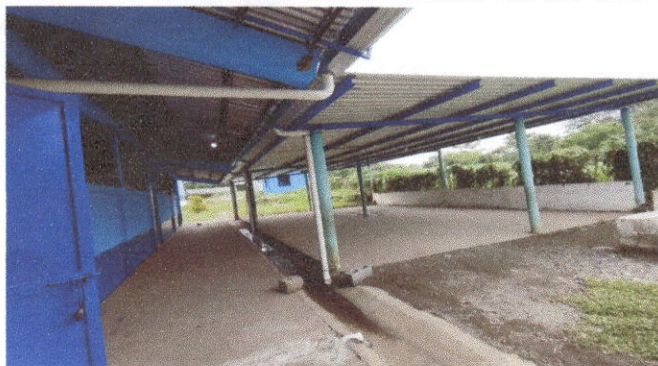
Foto 1: Cubierta de lamina.
