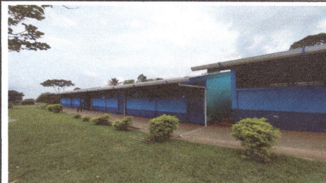
Foto 4: Canal y bajadas de agua pluvial.
