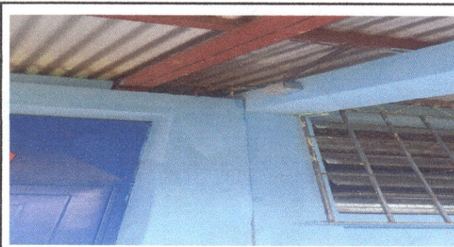
Foto 6: Reparación de sistema eléctrico.
